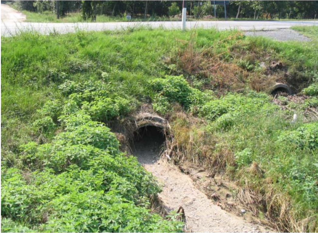
Foto 21 – Opera PENNAG019 . Ripresa da valle, sponda destra del rio.
