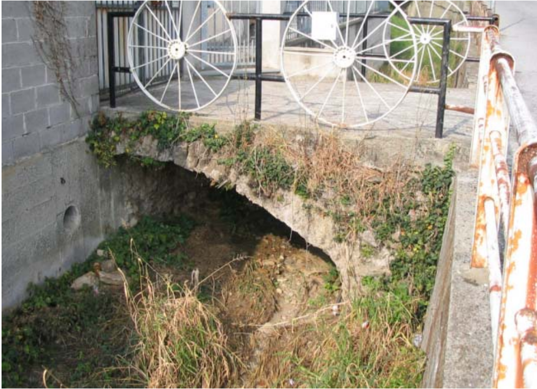
Foto 11 – Opera PENNAG009 . Ripresa da valle, dal muro PENNDS006.
