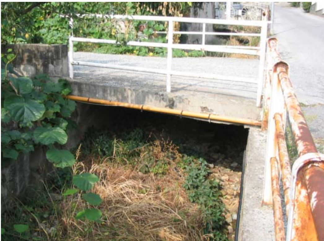
Foto 12 – Opera PENNAG010 . Ripresa da valle, dal muro PENNDS006.
