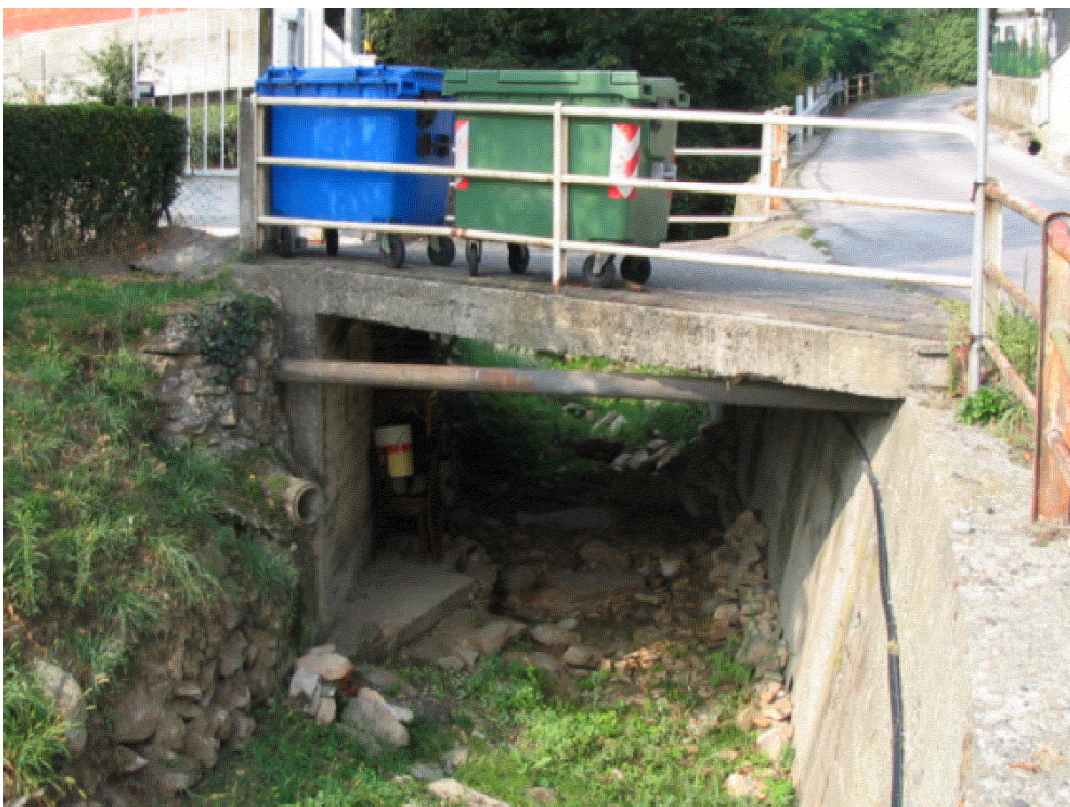
Foto 11 – Opera PENNAG008 . Ripresa da valle dal muro PENNDS006 .
