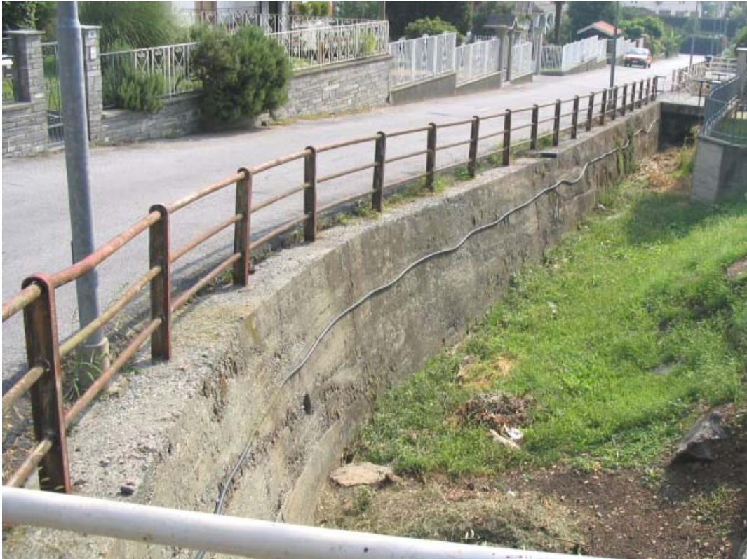
Foto 31 – Opera PENNDS006 . Ripresa da monte, dall'attraversamento PENNAG008 .
