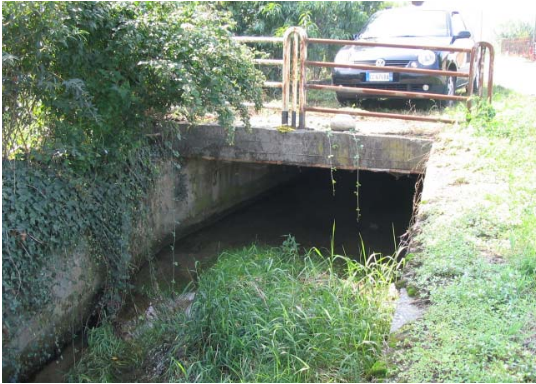
Foto 29 – Opera PENNCA011 . Ripresa da valle, sponda sinistra del Bedale della Morra.
