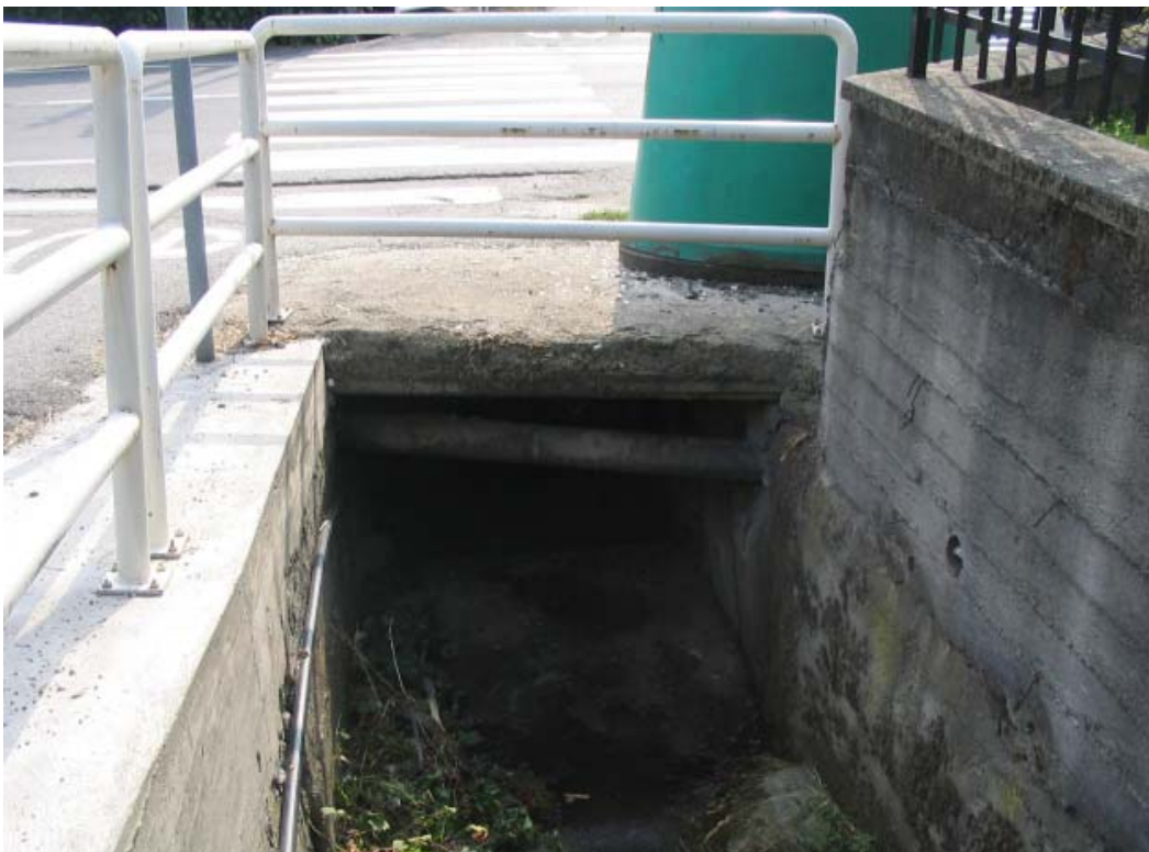
Foto 14 – Opera PENNAG012 . Ripresa da monte, dall'attraversamento PENNAG011
