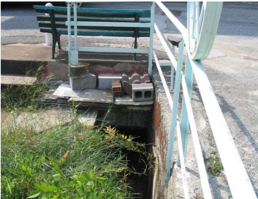
Foto 24 – Opera PENNCA006. Ripresa dello sbocco di valle.
