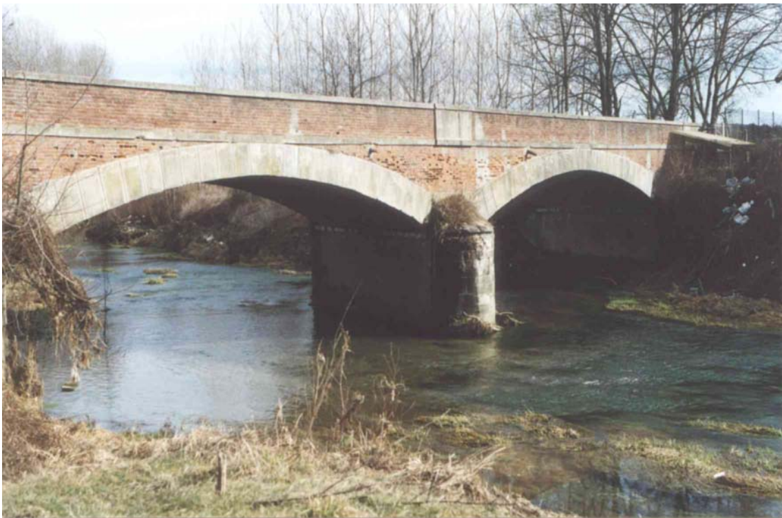
Foto 6 – Opera BATTPO006 . SS 589 Saluzzo-Pinerolo, sul Torrente Ghiandone. Vista da monte.
