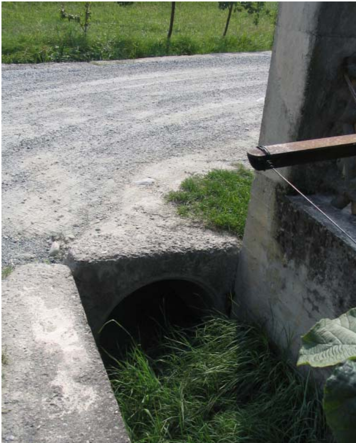
Foto 19 – Opera PENNAG017 . Ripresa da monte, sponda sinistra del rio.
