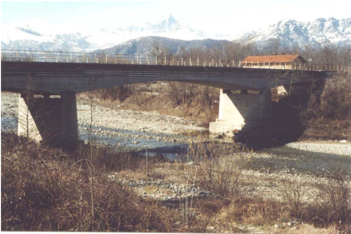
Foto 5 – Opera BATTPO005 . SS 662 Saluzzo-Revello, sul F. Po. Vista da valle.
