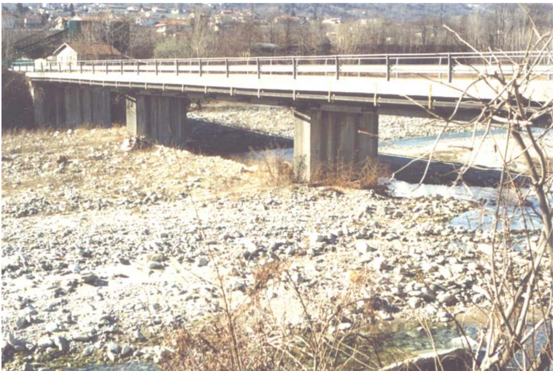
Foto 2 – Opera BATTPO002 . SP 26 Revello-Martiniana Po, sul F.Po. Vista da valle.
