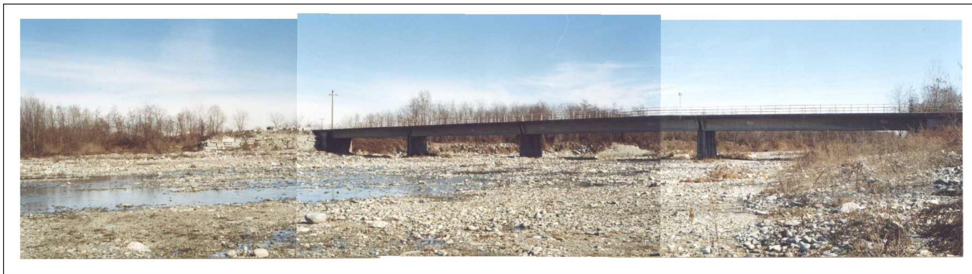
Foto 4 – Opera BATTPO004 . Ponte S. Ilario sul F. Po (strada di raccordo dell'abitato di Revello con la SP 260 Martiniana Po-Saluzzo). Vista da monte.
