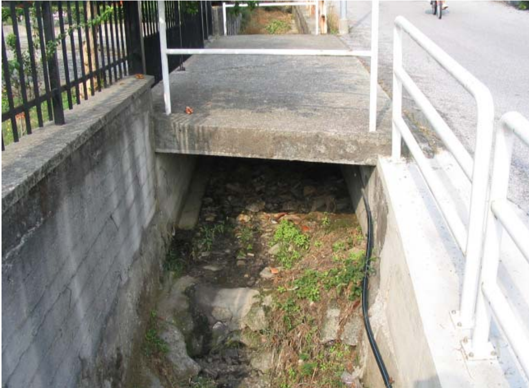
Foto 13 – Opera PENNAG011 . Ripresa da valle, dall'attraversamento PENNAG012 .
