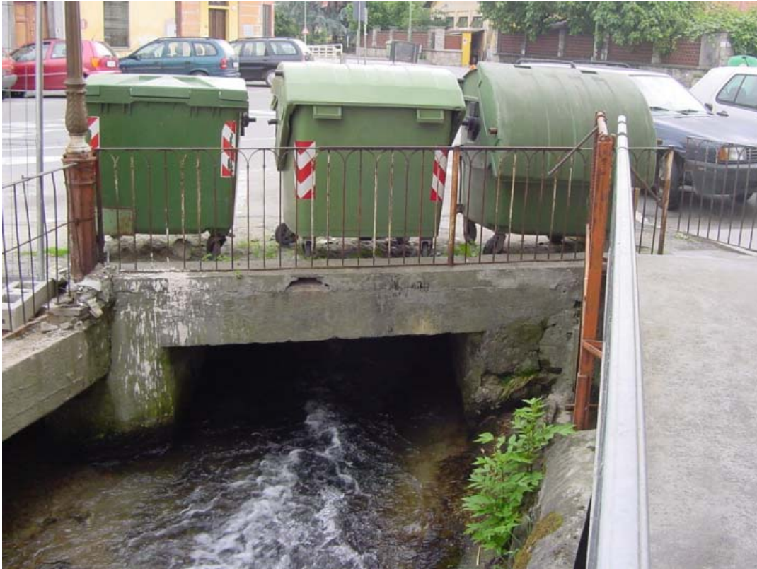
Foto 9 – Opera FERRCA003 . Ripresa dell'imbocco a monte.
