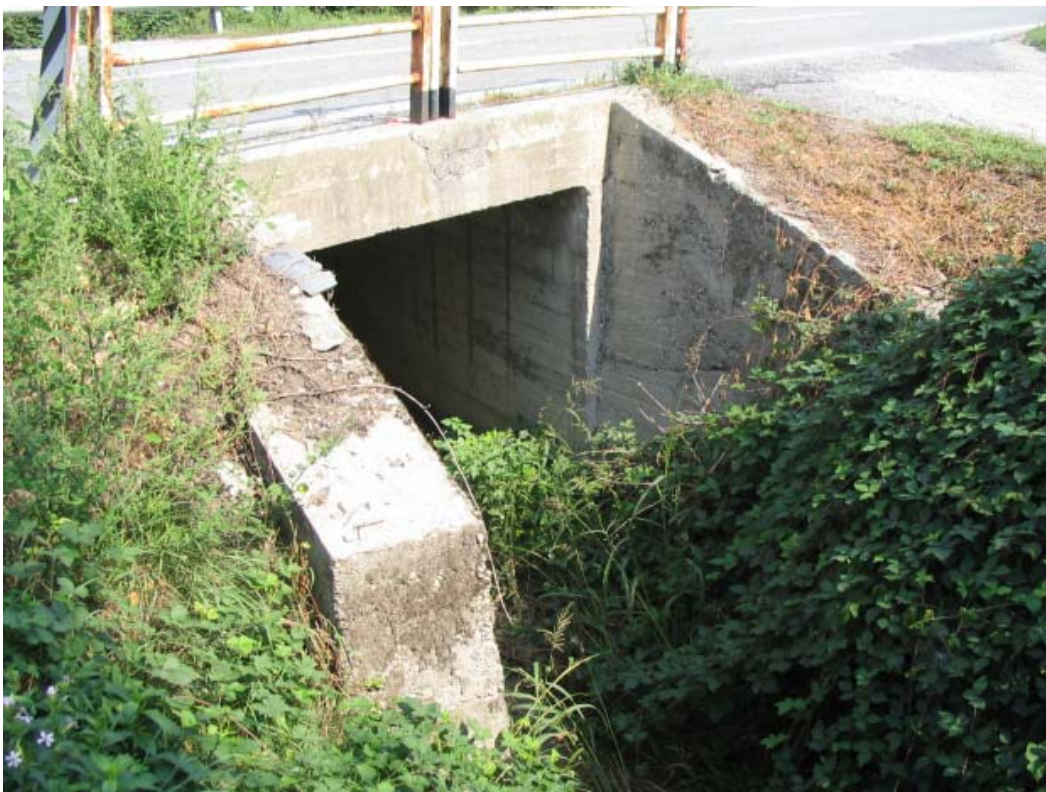
Foto 20 – Opera PENNAG018 . Ripresa da monte, sponda sinistra del rio.
