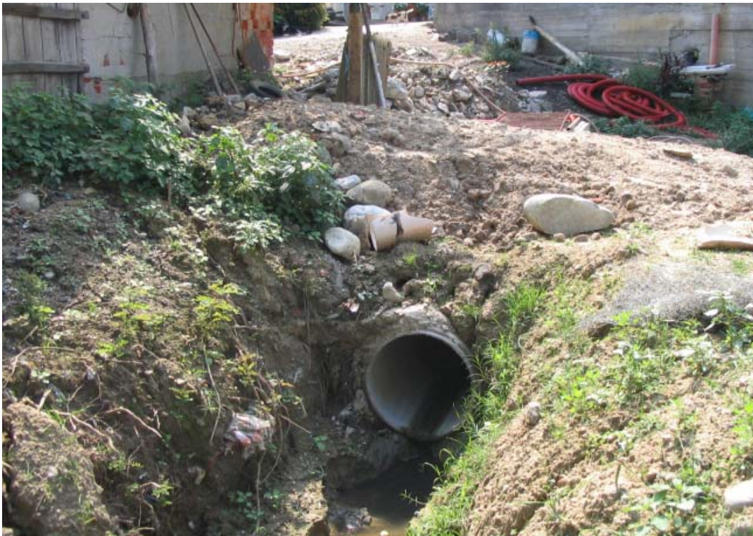
Foto 28 – Opera PENNCA010 . Ripresa dello sbocco di valle, sponda sinistra del rio.
