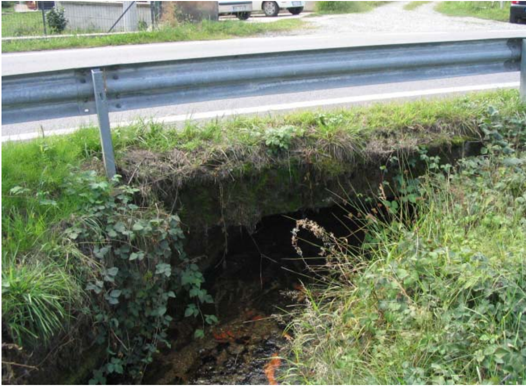
Foto 27 – Opera PENNCA009 . Ripresa dello sbocco di valle, sponda sinistra del Bedale della Morra.
