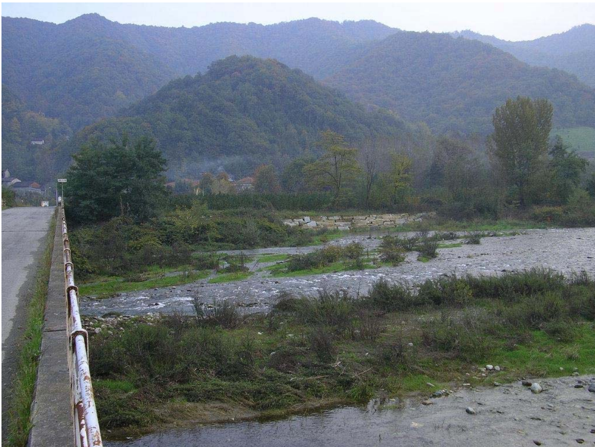
Foto 15 – Opera ZANEDS004 . Sponda destra, a monte dell'opera BATTPO004 .
