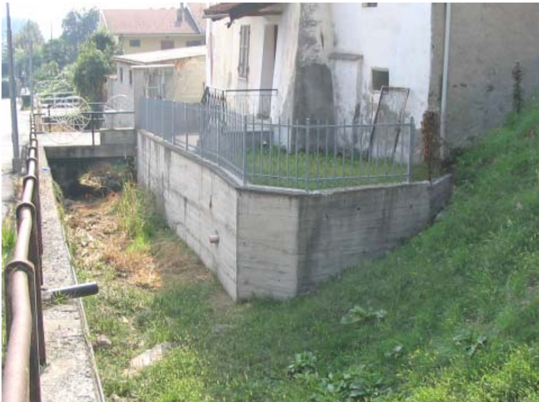
Foto 30 – Opera PENNDS005 . Ripresa da monte, dall'attraversamento PENNAG008.
